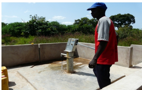
Le nouveau forage
