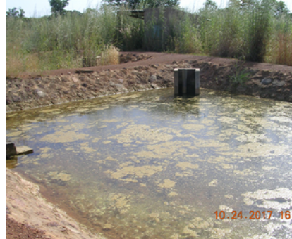
La réserve d'eau, pour la pisciculture ou l'arrosage, selon la nécessité
