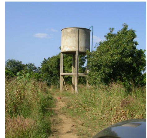
Le château d'eau
