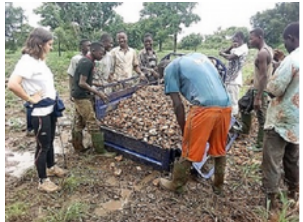
Les pierres locales servent pour les fondations
