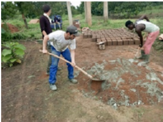
Les briques de terre sèche: les bancos, sont fabriqués avec la terre locale
