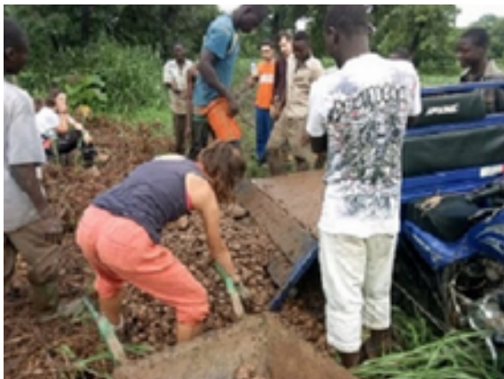
Les briques de terre sèche: les bancos, sont fabriqués avec la terre locale
